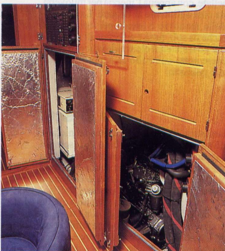
Su questo lato l'accessibilità al vano motore è ottimale, con due portelli molto ampi; sull'altro lato occorre migliorarla.
